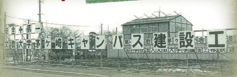
湘南校舎工事中
